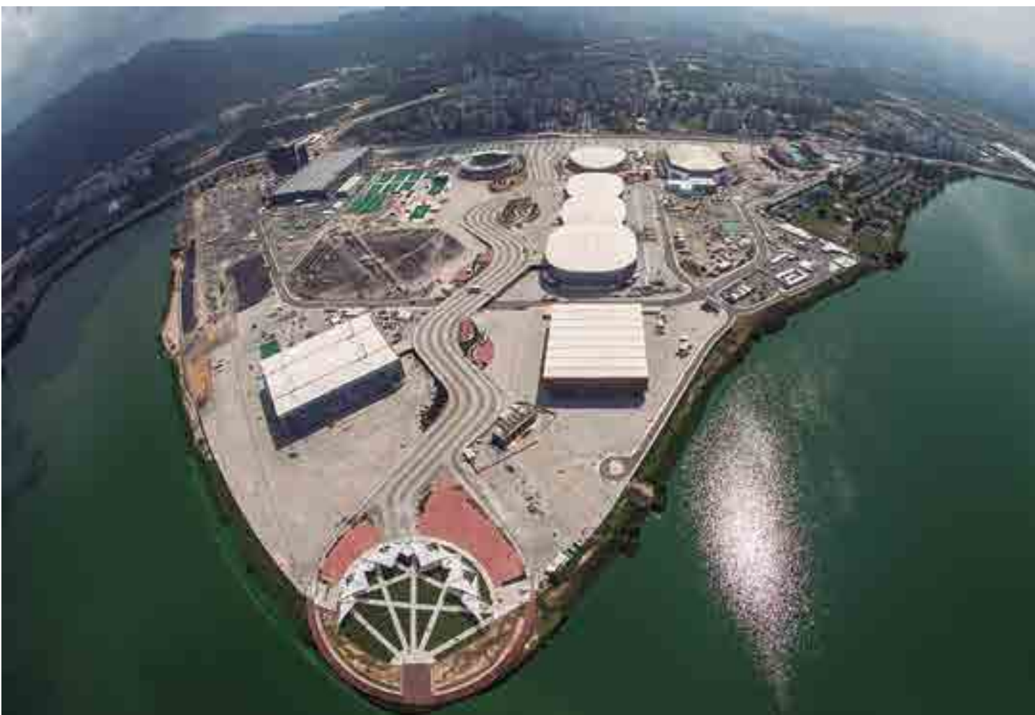
Em Manaus e no Rio de Janeiro, os investimentos puxaram a alta, sendo que, na capital fluminense, os Jogos Olímpicos foram os responsáveis pelo aumento nas obras públicas
